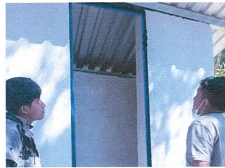
Foto 4: sustitución de puertas, repello y pintura de paredes inrior y exterior, sustitución de tazas de tazas de 2 baños
